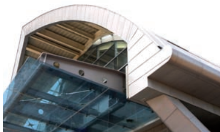
Fot. 1 Pokrycie dachu
