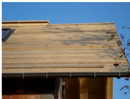
Fot. 8 Deskowanie pełne
