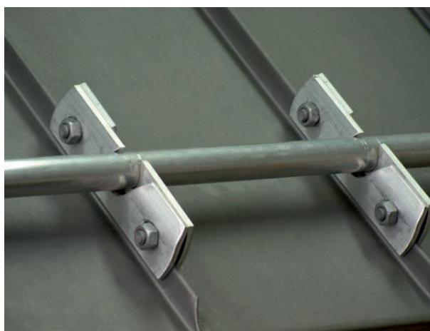
Rys. 7 Sposób mocowania elementów zabezpieczających do rąbka
