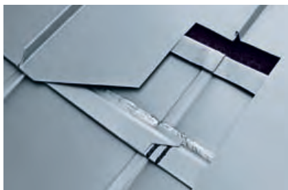
Optymalne wykonanie: dodatkowy pas wlotowany
