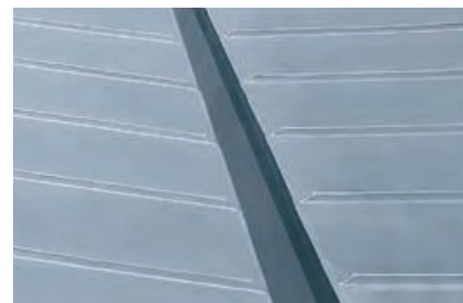
Rynna wewnętrzna skrzynkowa z wyklejaną rynną zabezpieczającą
