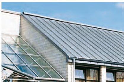
Kalenica dachu jednospadowego na listwę
