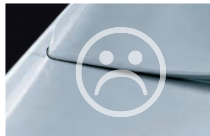
Kalenica dachu jednospadowego bez zapasu na rozszerzenie i o zbyt małym odgięciu
