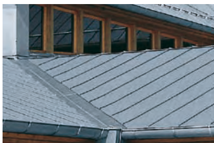
Kosz z rąbkim pojedynczym oraz pasem włutowanym
