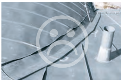
Kosz z bocznymi połączeniami na rąbek
