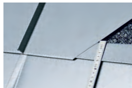
Połączenie poprzeczne: rąbek pojedynczy
